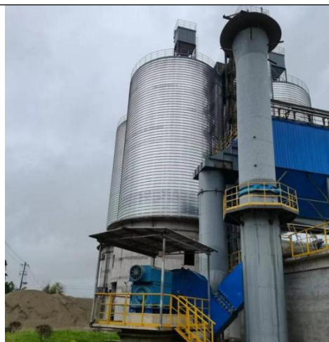
热风炉除尘器、排气筒
