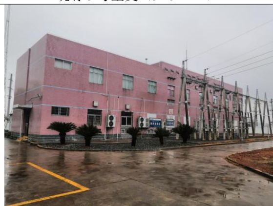
主控综合楼和 35kV 构架
